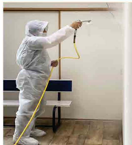
完全衛生管理施工
